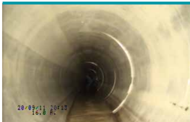
Tubería Rehabilitada
