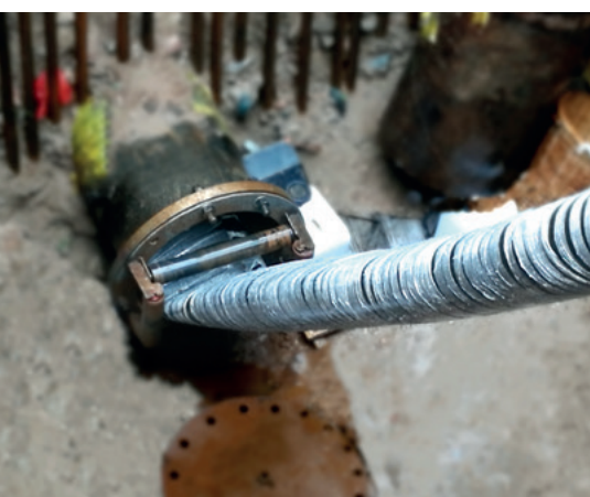
EL NORDILINER es la solución óptima para la rehabilitación de tuberías de presión sin apertura de zanja
